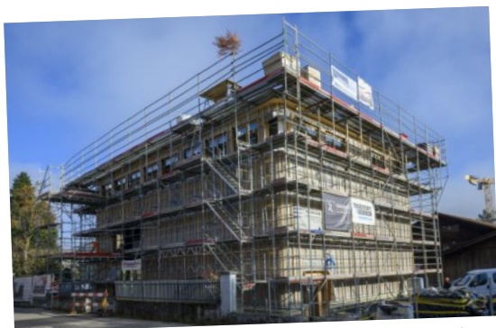
Poursuite des travaux de construction du Centre de Recherche et de Conservation.
