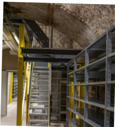
Réaménagement des caves du Château de Porrentruy.
